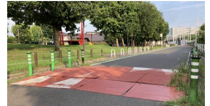
ハンプ(凸部):車の速度を落とすことを目的とし、道路上に設置されるものです。
